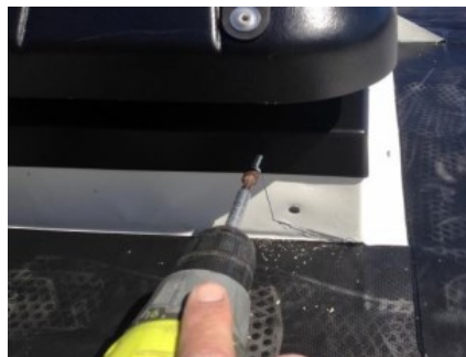
8) Fasten fan to curb.
